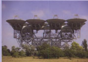
Антенна АДУ 1000. Сборка из 8 зеркал диаметром 16 м каждое. Первая антенна для работы с межпланетными космическими аппаратами. Работает в дециметровом диапазоне волн. Эффективная площадь 6700 м<sup>2</sup>. Разработана в шестидесятых годах двадцатого столетия.
