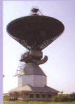
Антенна КТНА-200. Диаметр зеркала 25 м. Работает в дециметровом диапазоне волн. Эффективная площадь 240 м<sup>2</sup>. Разработана в 1965 г.
