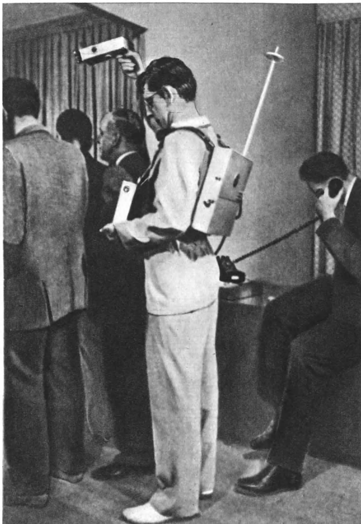
В правой руке репортера камера с миниатюрным видиконом; левой рукой он придерживает очень маленький, контрольный приемник, по экрану которого репортер контролирует качество изображения; в ранце, за спиной,— телепередатчик.
