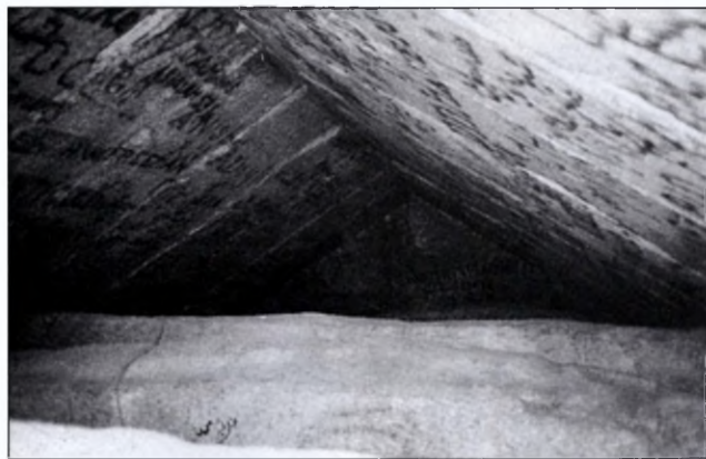
Илл. 6 (справа). Камера леди Арбатнот. Обратите внимание на огромные гранитные монолиты, образующие низкий плоский потолок. Каждый из них весит 80 тонн!
