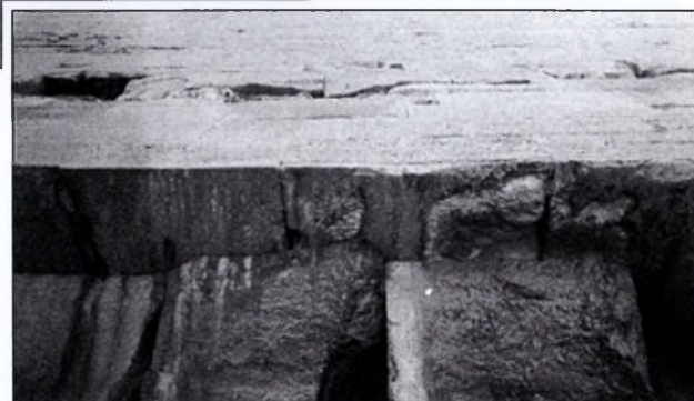
Илл. 21 (справа). Облицовочные блоки на северной стороне Ломаной пирамиды. Помимо высокого качества обработки наружных поверхностей, этот снимок показывает плотное смыкание облицовочных блоков с блоками ядра кладки за ними.
