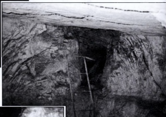
Илл. 48 (справа). Вход в туннель, ведущий с третьего уровня Водяного колодца. Туннель расположен в северо-западном углу, в скальном ложе над рвом.
