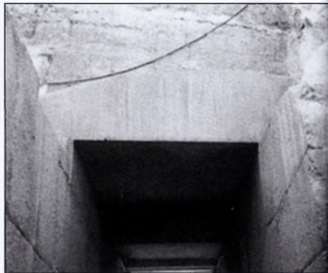
Илл. 34 (внизу). Западный портал Храма в Долине. Хорошо видна гранитная облицовка под массивным известняковым перекрытием.
