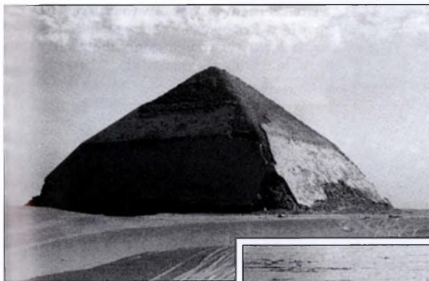
Илл. 21 (справа). Облицовочные блоки на северной стороне Ломаной пирамиды. Помимо высокого качества обработки наружных поверхностей, этот снимок показывает плотное смыкание облицовочных блоков с блоками ядра кладки за ними.
