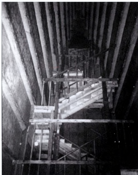
Илл. 22 (слева). Сводчатая кровля в Северной пирамиде Снофру в Дахшуре. Она послужила прототипом Большой галереи Великой пирамиды. На снимке показана также современная лестница, возведенная для удобства доступа в Верхнюю камеру.
