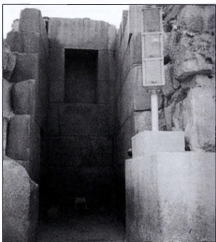
Илл. 14 (вверху). Правый вход в Храм в Долине. Гранитные блоки облицовки стен тщательно отбесаны и до сих пор находятся в хорошем состоянии, благодаря тому, что в течение тысячелетий были скрыты под слоем песка.
