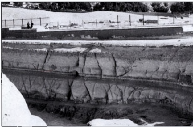
Илл. 32 (справа). Эрозия на северной и западной стенах ограды Второй пирамиды. В них видны острые трещины, резко контрастирующие с более округлыми следами эрозии на ограде Сфинкса.
