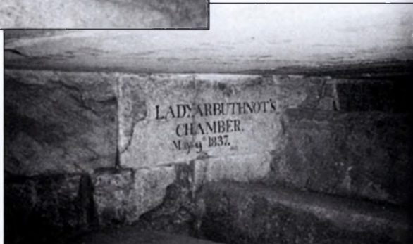
Илл. 6 (справа). Камера леди Арбатнот. Обратите внимание на огромные гранитные монолиты, образующие низкий плоский потолок. Каждый из них весит 80 тонн!
