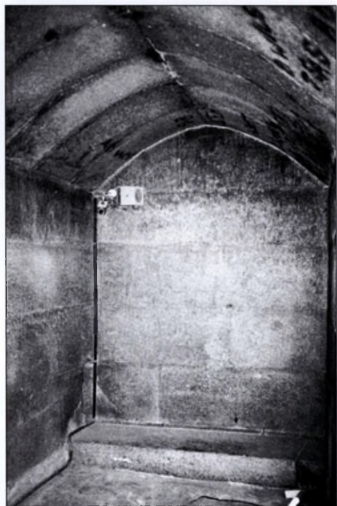
Илл. 12 (справа). Нижняя камера в Третьей пирамиде. Помимо камеры Царя в Великой пирамиде, это единственная из камер в трех больших пирамидах в Гизе, облицованная гранитом. Именно в ней Вайс обнаружил пустой базальтовый саркофаг, который впоследствии был утрачен на пути в Англию.
