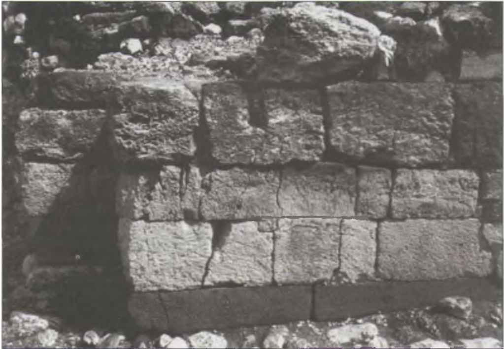
Фрагмент ворот Мегиддо (слой VIII) с тремя рядами каменной кладки на базальтовом фундаменте. Между третьим и четвертым рядом известняковых блоков строители положили кедровые балки (ныне сгнившие), а промежутки заполнили щебенкой.
