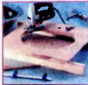
2. Вырезать отверстие для раковины вам поможет электролобзик.
