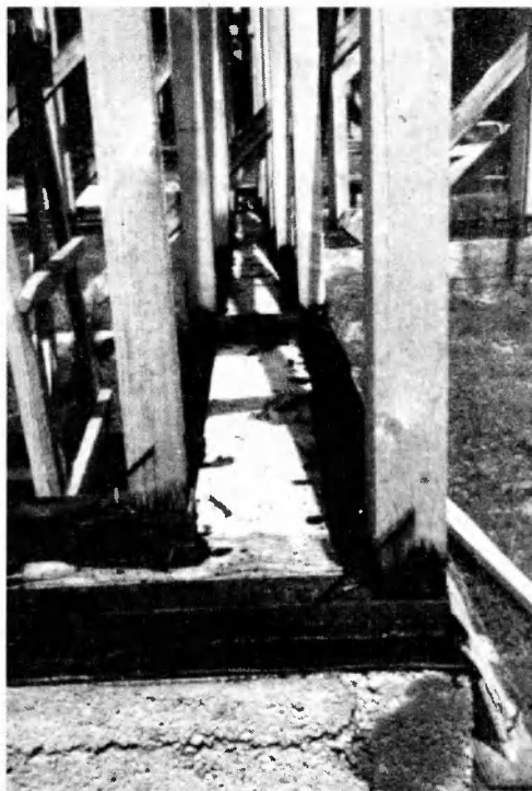
Так монтируется каркас на фундаменте.
