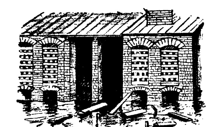
Здание ванной печи, санитов воды
