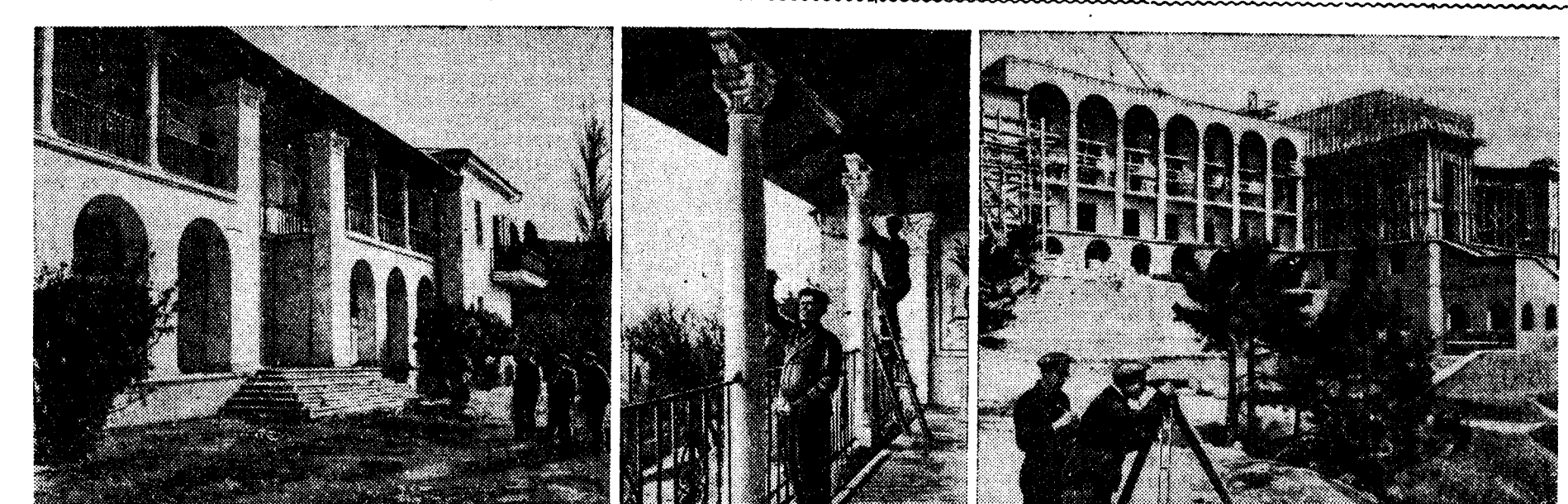
На Южном берегу Крыма расширяется сеть здравниц. В Алушке сооружается санаторий «Белоруссия». Уже возведены спальный, лечебный, административный корпус. В Нижнем Мисхоре, у самого моря, строится санаторий для работников лесной и бумажной промышленности. НА СНИМКАХ (слева направо): общий вид спального корпуса санатория «Белоруссия»; отделочные работы на одном из балконов его главного корпуса; общий вид строительства санатория для работников лесной и бумажной промышленности. Фото Н. Киреева.
