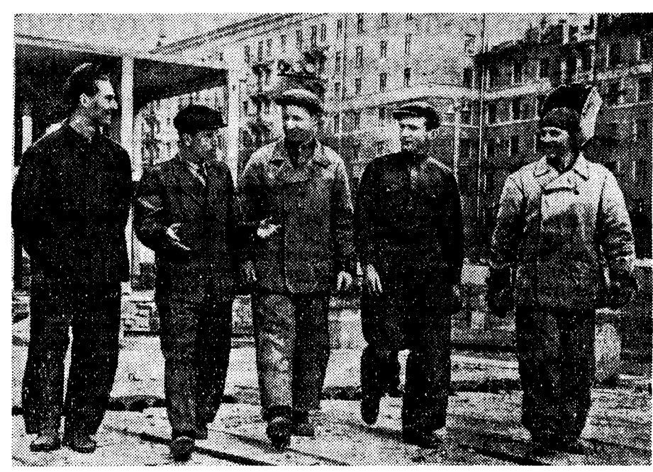
Демобилизованные воины сейчас отлично трудятся на мирном поприще — новостройках столицы. На снимке: переводы рабочие стройуправления № 3 треста «Мосжилстрой» (слева направо): электромонтер И. Филин, старший мастер В. Савинов, бригадир монтажников В. Подобедов и В. Алдунин, электросварщик В. Холин.
