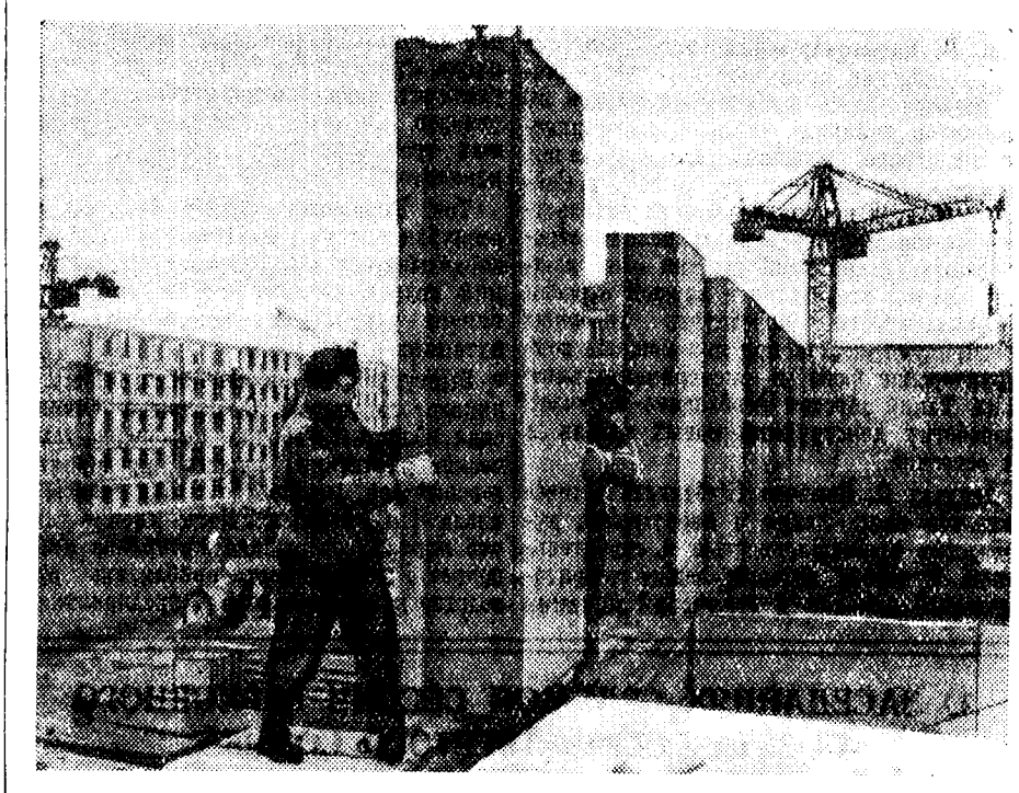
Крупноблочное строительство в 12-м квартале в Новых Черемушках. Здесь строится 16 пятиэтажных жилых домов из крупных блоков. Фото В. Зунина.
