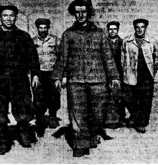
РАСТЕТ и благоустривается столица Туркменин — город Ашхабад. Сейчас здесь ведутся большие работы по сооружению нового водовода. Вода будет подаваться из скважины, расположенной в предгорьях Копет-Дага. Протяженность этой водной артерии — 22 километра. С пуском нового водовода количество потребляемой городом воды немного увеличится. На снимках: слева — укладка труб в траншею, справа — комплексная бригада треста «Туркменнефтестрой», носящая почетное звание коллектива коммунистического труда: монтажники Н. Катлобай, бригадир Г. Гурель, монтажники П. Резцов, сварщик А. Кандили, монтажники А. Голубов и К. Самаков.
