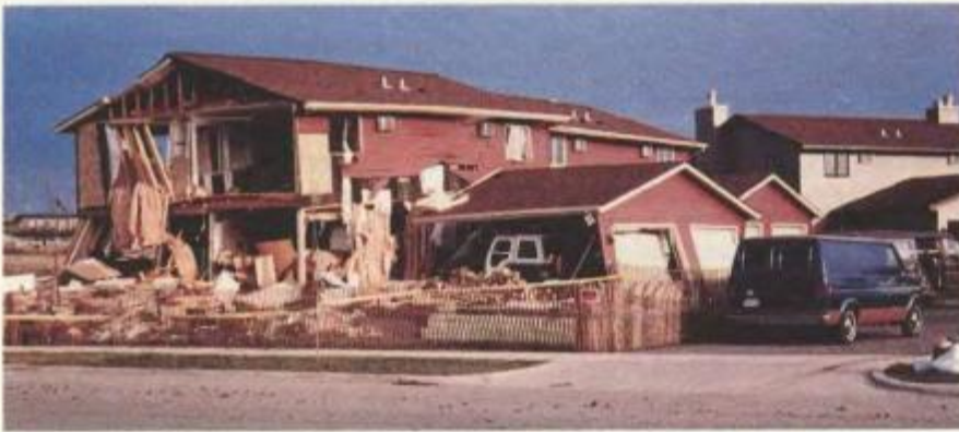
ДОМ в Мадисоне (шт. Висконсин), расположенный через дорогу от закрытого полигона с отходами, 19 ноября 1983 г. пострадал от взрыва. Образовавшийся в результате разложения отходов метан просочился под землей в помещение и взорвался. Двое жильцов погибли. После этого случая на полигоне была установлена система контроля за выделяющимся метаном.
