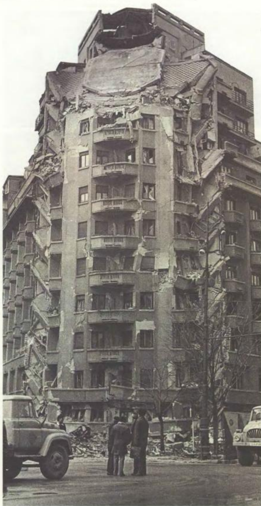
РАЗРУШИТЕЛЬНЫЕ ГЛУБОКИЕ ЗЕМЛЕТРЯСЕНИЯ — редкое явление. За последние десятилетия единственный толчок такого рода произошел 4 марта 1977 г. на глубине 150 км под Бухарестом. При этом погибло 1500 человек. На первом этаже изображенного на фотографии здания обрушились колонны, в результате чего угол его опустился на один этаж. Снимок сделан Н. Мандреску из Института физики Земли в Бухаресте.
