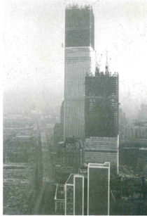
Во время строительства башен-близнецов хорошо виден их внешний стальной каркас.
