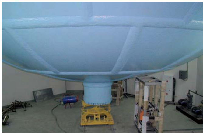
Крышка нижнего люка весит 600 кг, для ее отвода используется специальная тележка.
