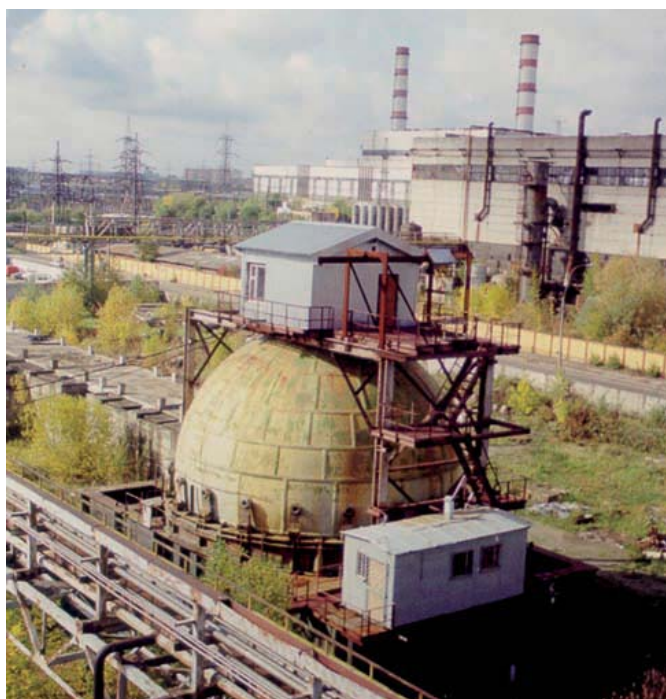
Сферическая камера 13ЯЗ объемом 900 м 3
