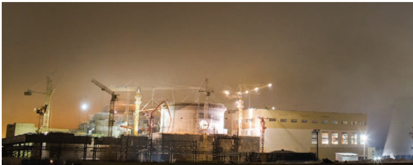
Строительство энергоблока Нововоронежской АЭС-2
