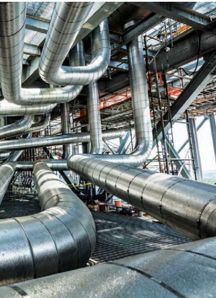
Для преобразования грязного угля в более чистое газообразное топливо и уменьшения выброса CO_2 в атмосферу электростанции Кетпер потребовались 277 км труб, 40 тыс. т стальных конструкций и два гигантских газификатора (один из них виден в центре правого снимка)
