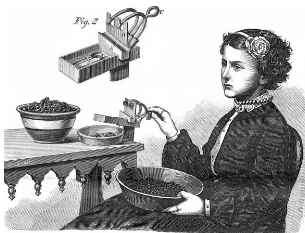
Удаление косточек из вишен — дело скучное; показанное устройство было создано для облегчения труда, 1868 г.
