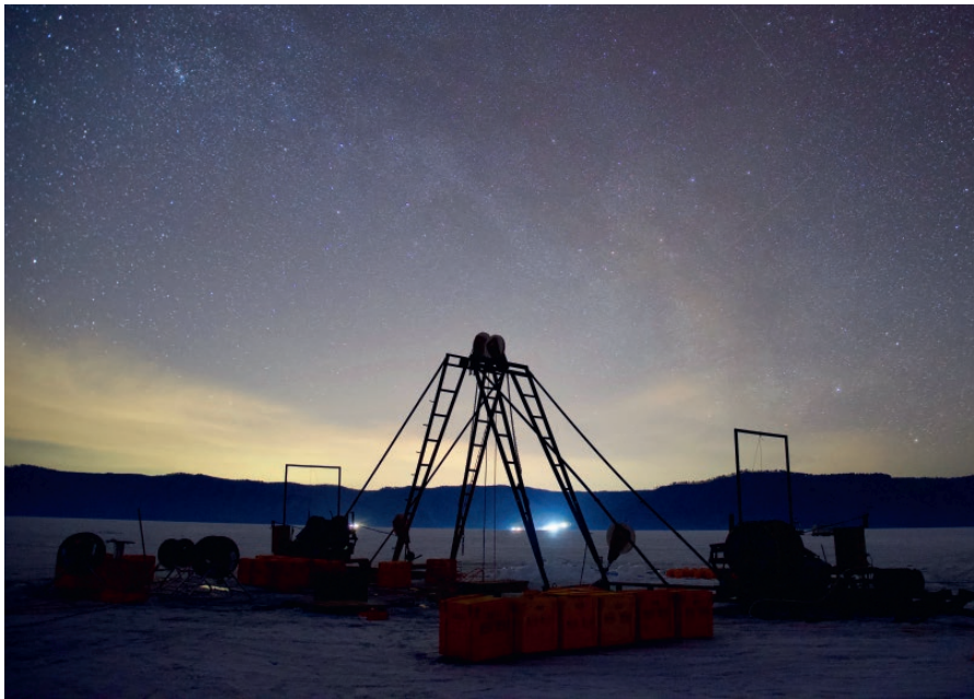
На протяжении двух месяцев в году Байкал покрывается прочным льдом, позволяющим вести монтажные работы. Фото: Б.А. Шайбонов / ОИЯИ.
