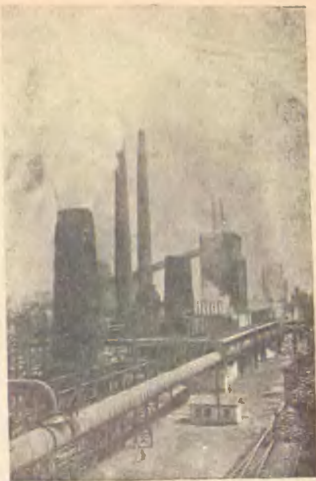
Магнитогорский металлургический комбинат им. Сталина. Тушильные башни коксовых батарей.
