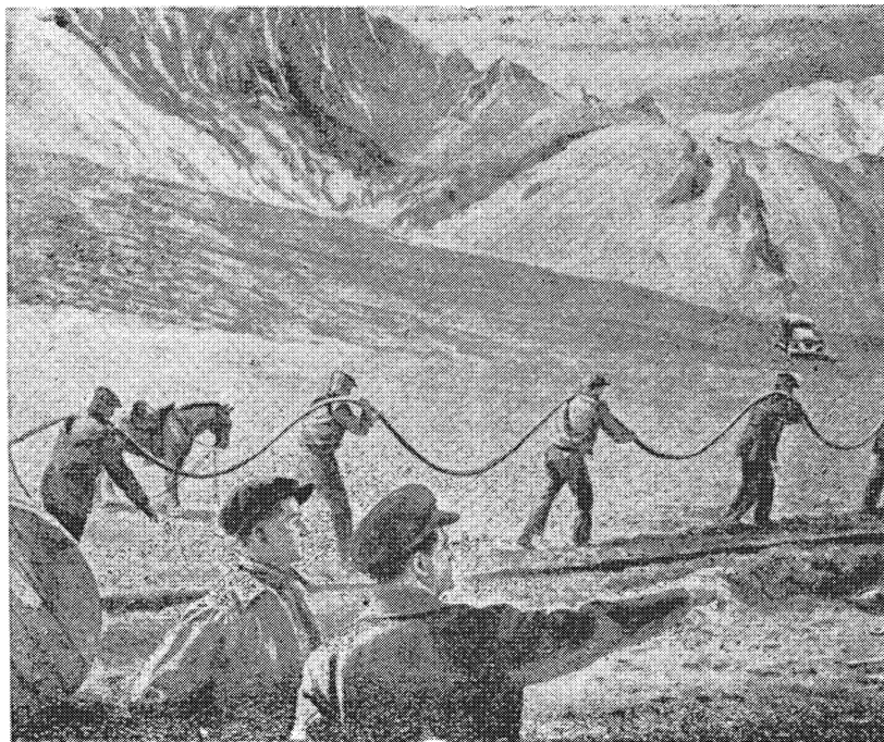
Прокладка телефонного кабеля в горах.
