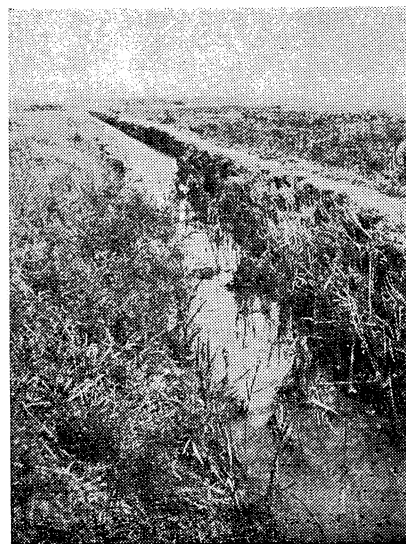
Арык, загрязненный илом.
