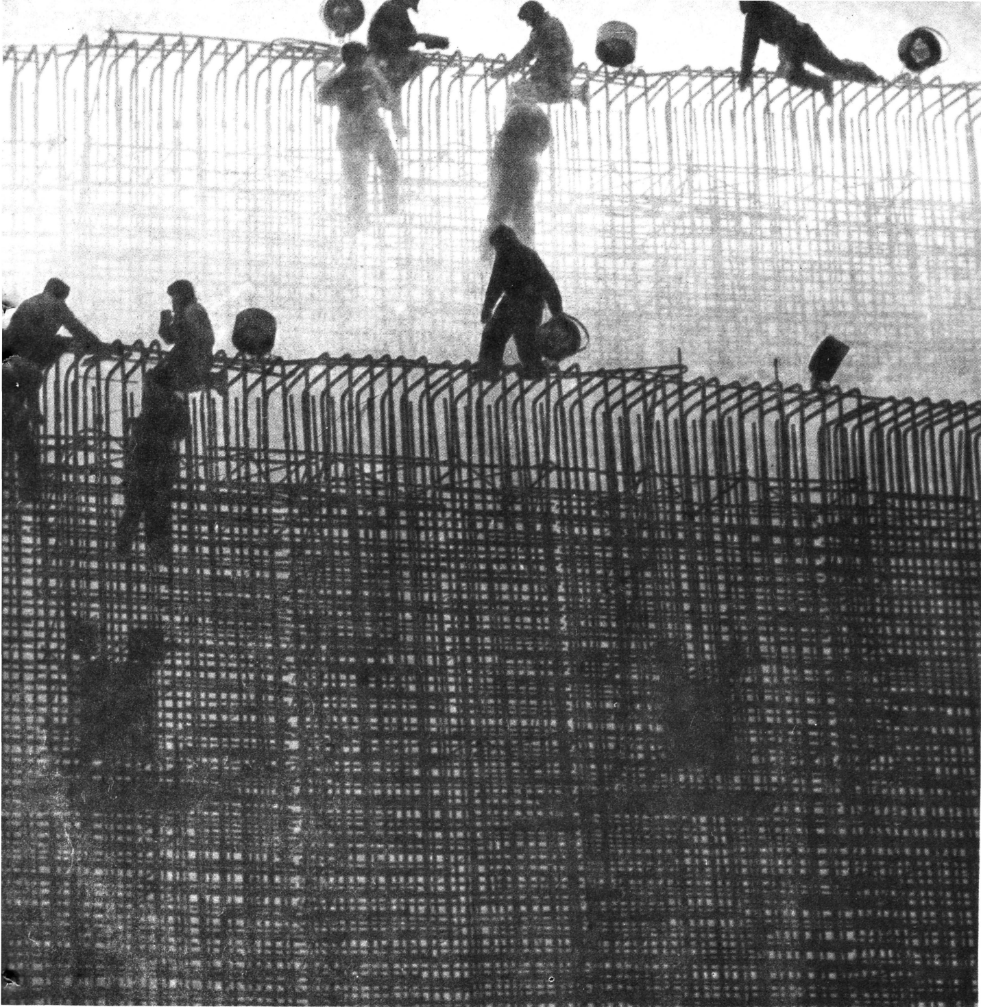
На Нововоронежской строится новый блок.
