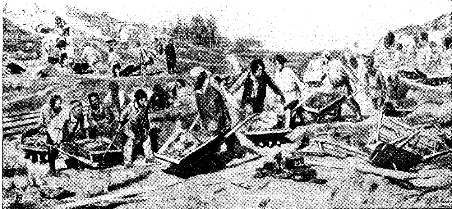
Ремонт железной дороги.
