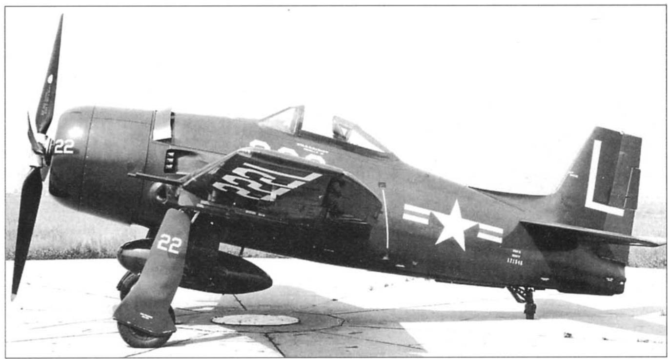
В 1948 году была введена цветная система обозначений эскадрилий морской авиации. Этот F8F-2 из VF-72 несет на киле большую белую букву, кок винта покрашен белым. Это обозначение второй эскадрильи в авианосной группе. Еще одна эскадрилья группы - VF- 71 эти же обозначения носила красными.
