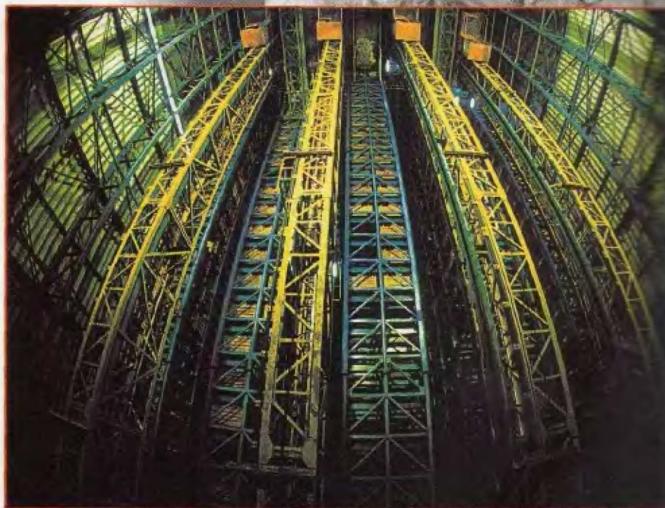
Лифтовая шахта небоскреба
