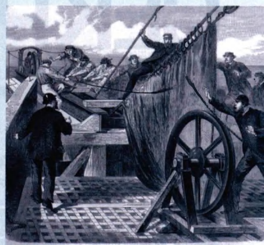
Во время прокладки первого кабеля произошел обрыв.
