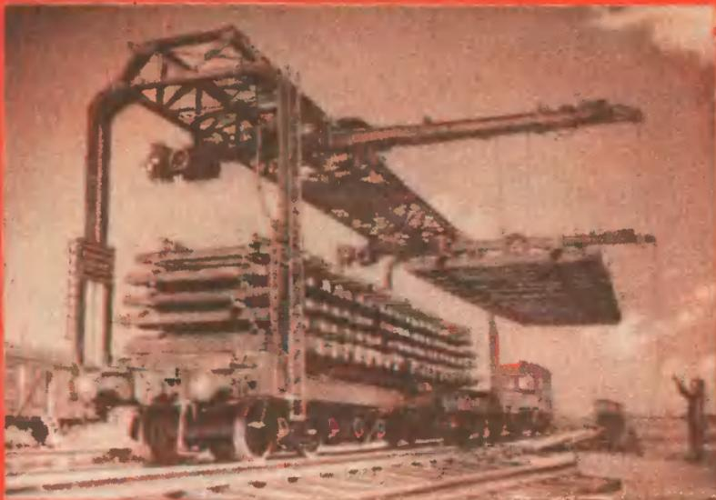
Второй путеукладчик на подготовленное основание укладывает двадцатипятиметровые отрезки усиленного пути. Отрезки пути делают на звеносборочной базе.
