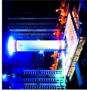
жайшем будущем. Высота трубы полноразмерного воздухоочистителя может достигать 500 м, а площадь прилегающей к ней оранжереи — 30 км<sup>2</sup>. Такие установки будут работать только за счет солнечной энергии, а накапливаемого ими в течение дня тепла будет достаточно для работы в темное время суток.
