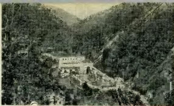
**СУХУМСКАЯ ГЭС** на реке Гумисте. Мощность — 20 тыс. квт. Вода к зданию гидростанции подводится тоннелем и затем трубопроводами к турбинам. Напор на станции равняется 230 м. Сдана в эксплуатацию в 1948 году. Станция предназначена для энергоснабжения города Сухуми и прилегающих к нему районов, а также питает энергией электрифицированную Черноморскую железную дорогу. Станция работает в единой энергетической системе Грузии и Северного Кавказа.
