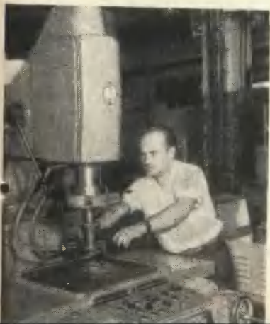
Универсальный ультразвуковой про- нижачный станок 4771. У станка ве-
