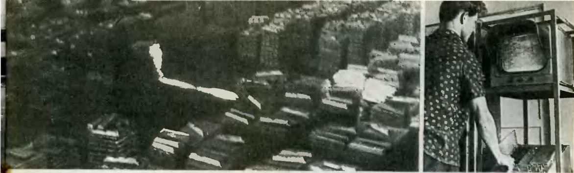
сложная и трудоемкая операция. Для облегчения труда рабочих советские инженеры и ученые создали специальные механизмы. Один из них — комбайн. Это самоходная машина, которая движется вдоль ряда электролизеров, производя необходимые технологические операции [пробивку корки электролита и засыпку очередной порции глинозема]. Сейчас на алюминиевых заводах страны проходит испытания принципиально новый механизм — самоходная порталная машина с автоматизированным управлением.
