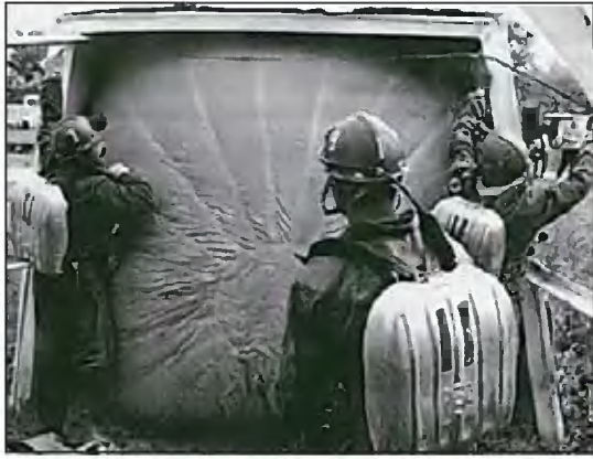
Идет монтаж перемычки.
