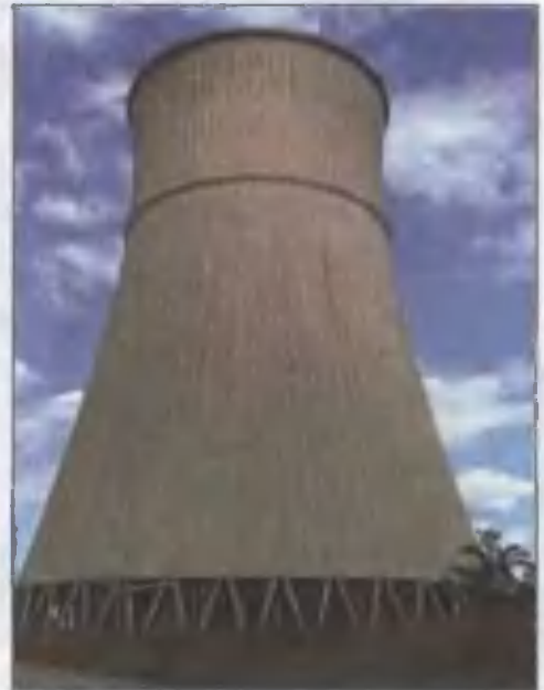
Рис. 3. Градирни электростанций часто имеют форму гиперboloида вращения.
