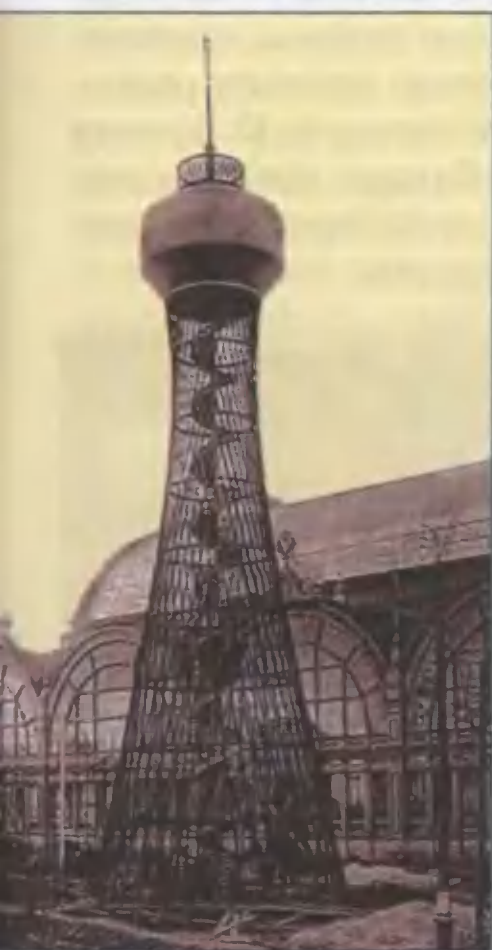
Рис. 1. Первая башня В.Г. Шухова, 1895 г. Ее красоту определила точность инженерного расчета и рациональность конструкции.
