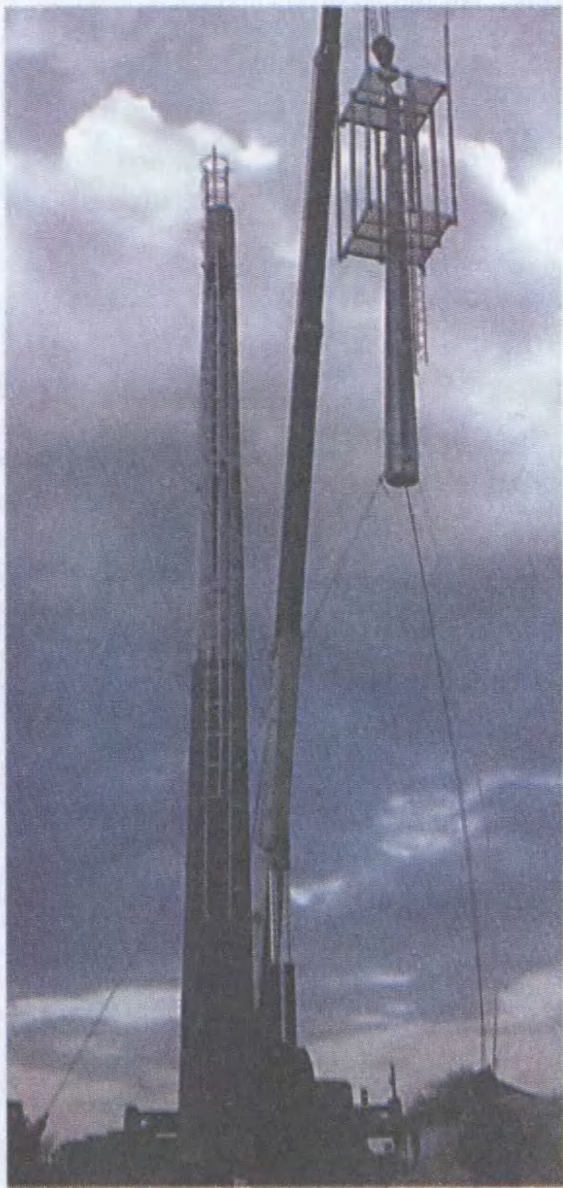
Монтаж многогранной башни нового поколения.
