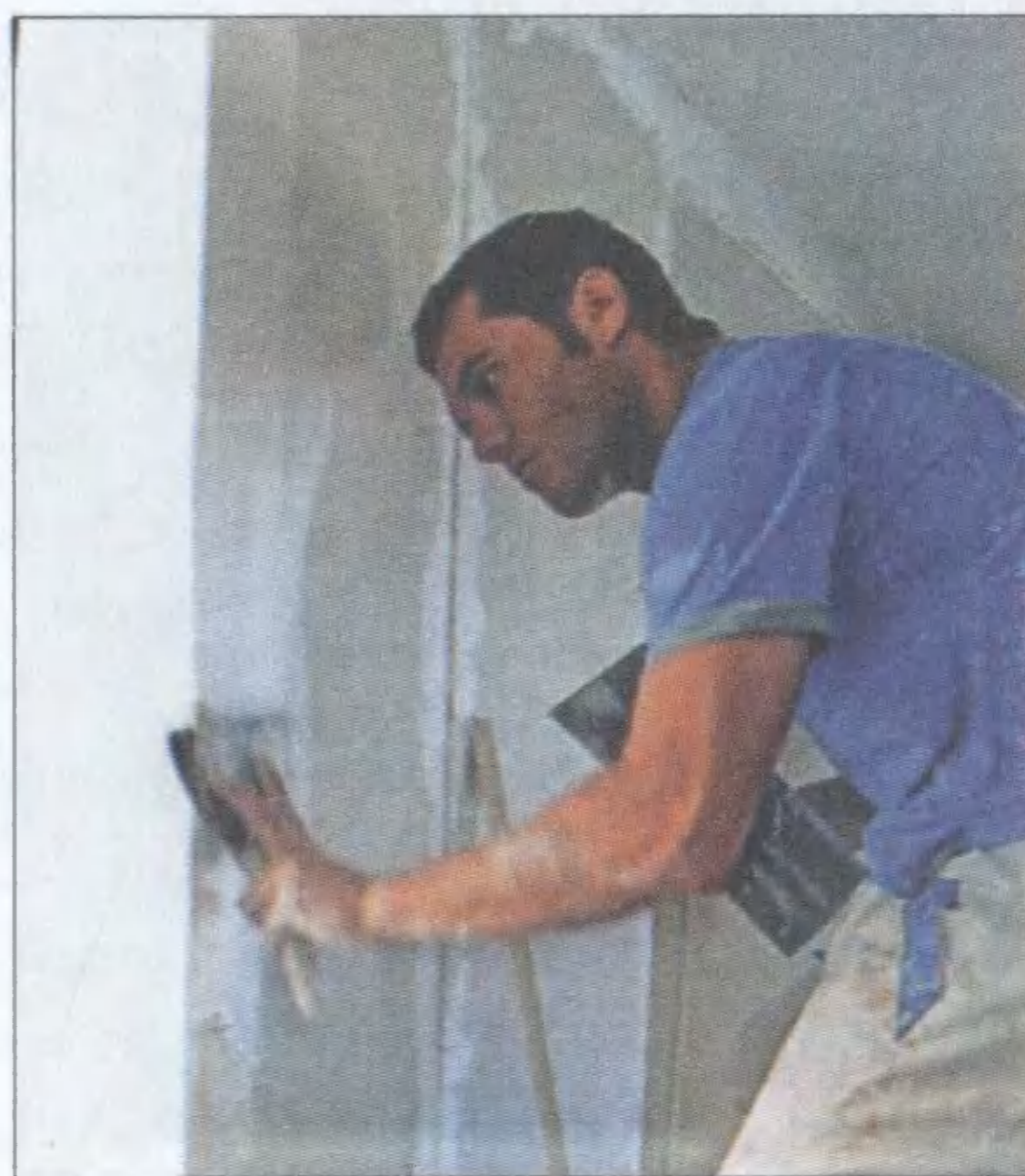
Грунтовку начинают с углов.
