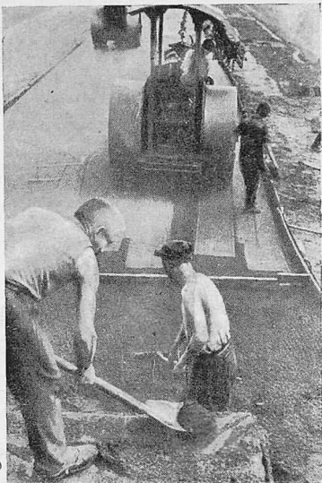
Укладка асфальта на Ленинградском шоссе (Москва).
