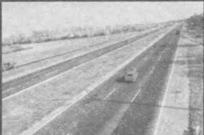
Участок дороги перед въездом в Киев.
