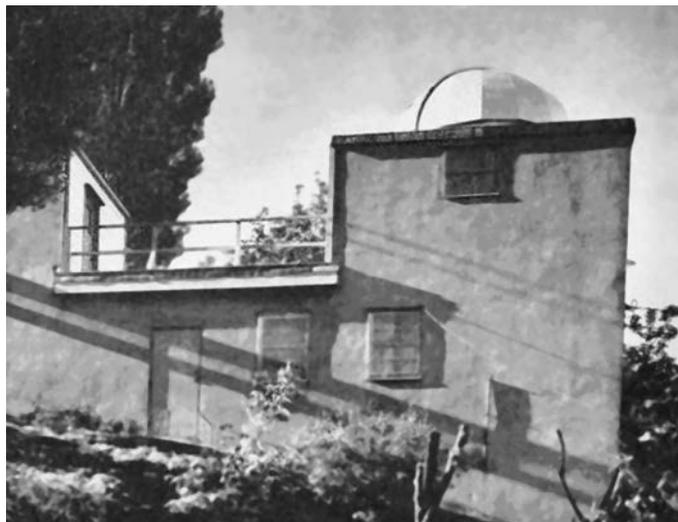
*Обсерватория в Окленде (Новая Зеландия), где разнесены в разные стороны башня с 500-мм рефлектором Кассегрена и теплое помещение. Журнал "Sky and Telescope", июль 1971 г.*
