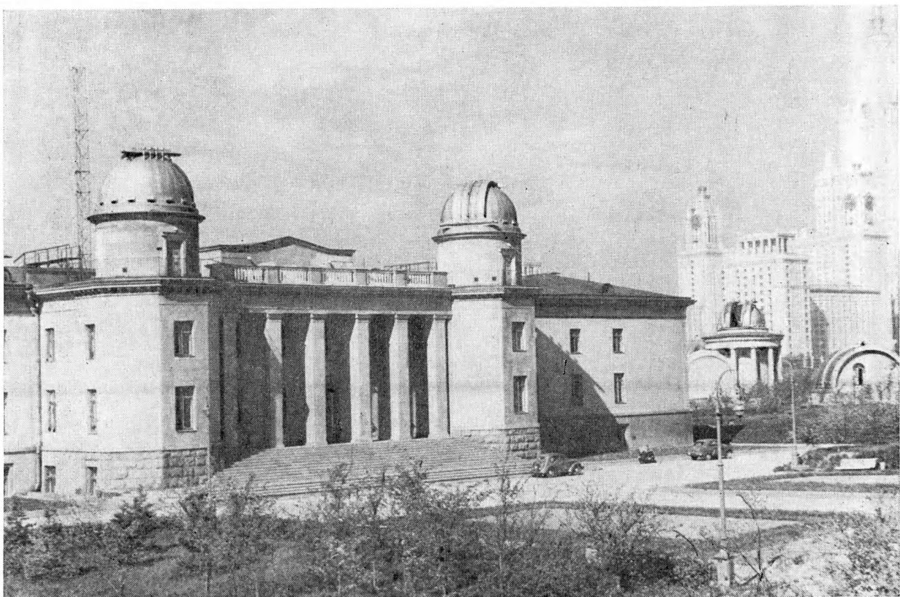
Здание ГАИШа на Ленинских горах
