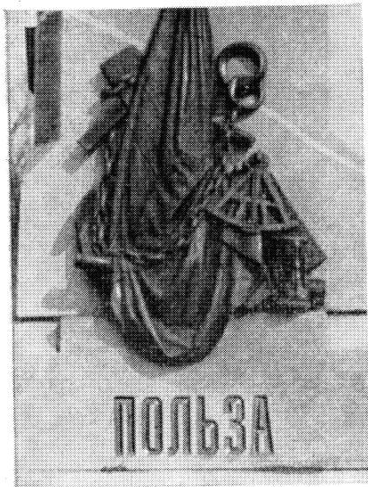
Фрагмент пьедестала памятника П. К. Пахтусову. Верхняя горизонтальная черта буквы «П» в слове «Польза» служит основным контрольным репером уровнемерной станции «Кронштадт»
