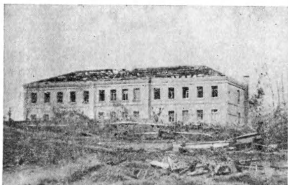
Кирпичный дом после смерча.
