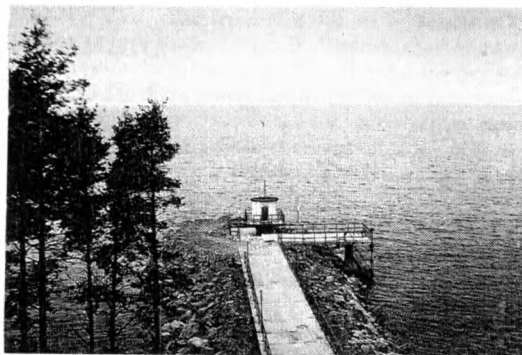
Шепелевский дублер Кронштадтского футштока (подпорная дамба, уровеньная рейка, колодец и будка мареографа)
