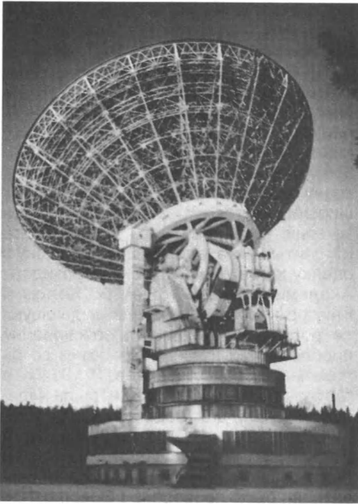
64-м радиотелескоп в Медвежьих Озерах под Москвой, участвующий в международной программе поиска внеземных цивилизаций по методу радиоинтерферометрии на сверхдлинных базах (РСДБ – VLBI)
