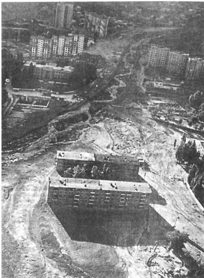
Город Тырнауз в Кабардино-Балкарии, затопленный мощным селевым потоком, вырвавшимся из ущелья правого притока р. Баксан в июле 2000 г.
