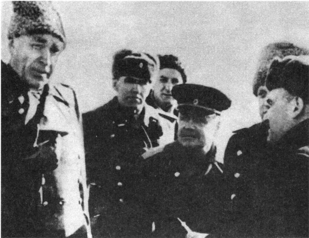
Г.М. Шубников (слева) и С.П. Королёв (справа) обсуждают ход строительства первого стартового сооружения. Начало 1957 г.
