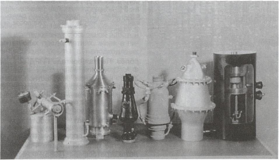
Макеты жидкостных ракетных двигателей Ф.А. Цандера, разработанных в ГИРД. Первый, второй и четвертый слева – ОР-1 (на гибридном топливе), ОР-2 и ЖРД для ракеты ГИРД-Х его конструкции.
