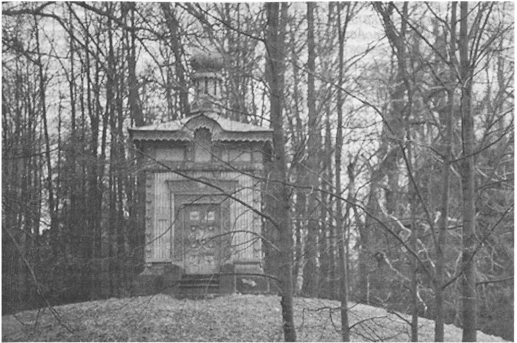
Южная мира – усыпальница, расположенная на территории Астрономической обсерватории им. В.П. Энгельгардта. Она стоит на насыпном холме, на краю большой поляны. Исполненная в “византийском стиле”, она по сей день восхищает посетителей обсерватории изящной строгостью своих форм.
