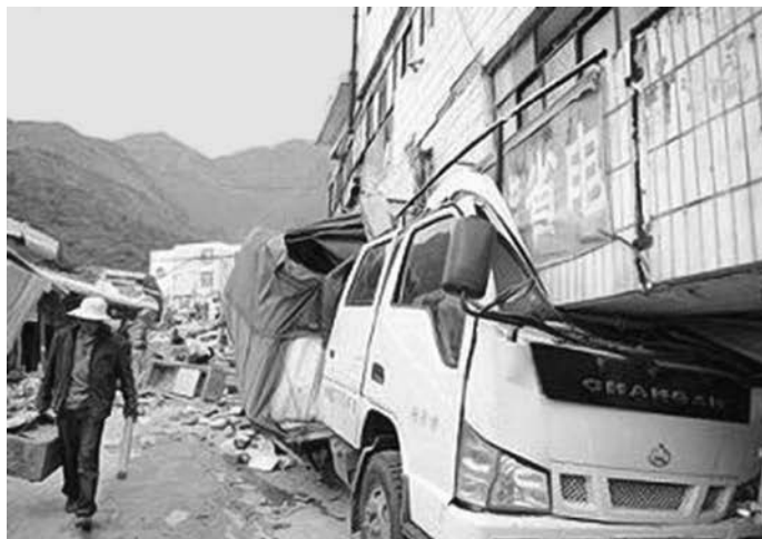
Последствия землетрясения в Китае 3 августа 2014 г.
