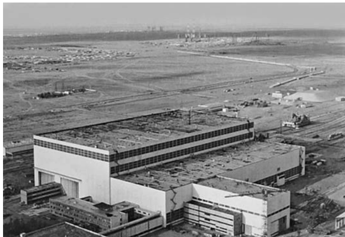
Монтажно-испытательный корпус РН “Энергия” и КК “Буран” на площадке № 112 космодрома Байконур.
