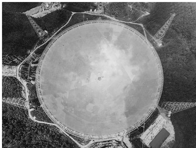
Радиотелескоп FAST диаметром 500 м (вид сверху), расположенный в провинции Гуйчжоу (Китай). По периферии круглого зеркала рефлектора расположены 6 опорных мачт. Фото CAS.
